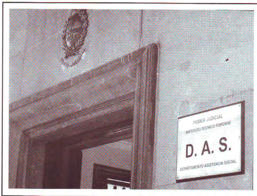
Fachada de la nueva sede en la calle Buenos Aires.
